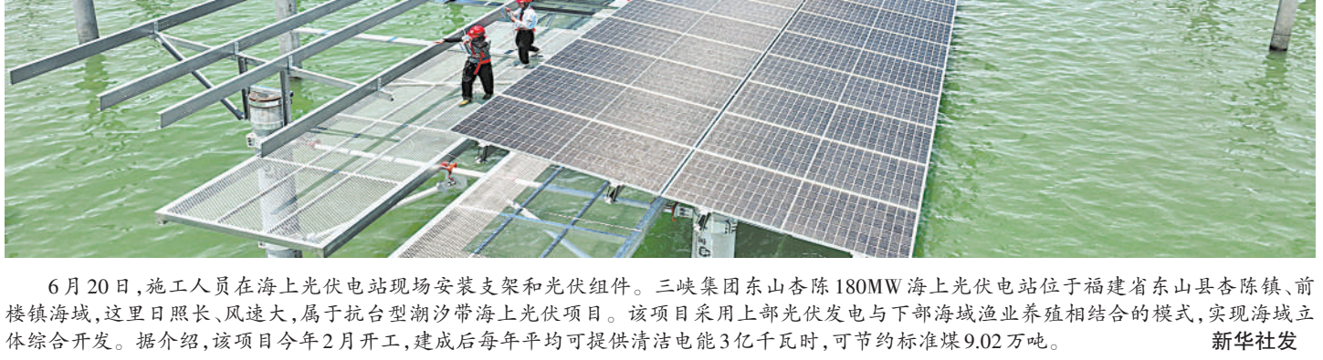
6月20日,施工人员在海上光伏电站现场安装支架和光伏组件。三峡集团东山杏林180MW海上光伏电站位于福建省东山杏林镇、前楼镇海域,这里日照长、风速大,属于抗台型潮汐带海上光伏项目。该项目采用上部光伏发电与下部海域渔业养殖相结合的模式,实现海域立体综合开发。据介绍,该项目今年2月开工,建成后每年平均可提供清洁电能3亿千瓦时,可节约标准煤9.02万吨。
