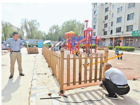
物业公司组织人员将旧围栏拆除清理。
