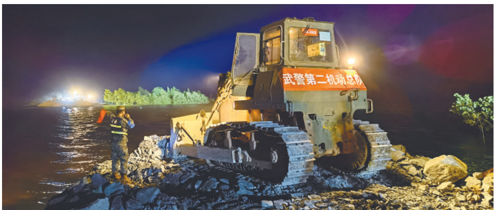
7月7日凌晨,在湖南省岳阳市华容县团洲垸洞庭湖一线堤防决口处,武警部队官兵操纵工程机械封堵决口。新华社发
