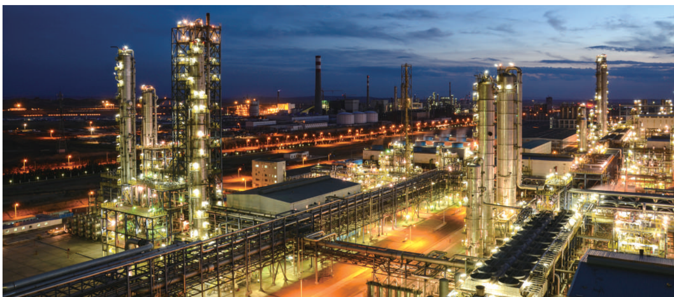
位于宁东能源化工基地的国家能源集团宁夏煤业有限责任公司400万吨/年煤间接液化示范项目。
