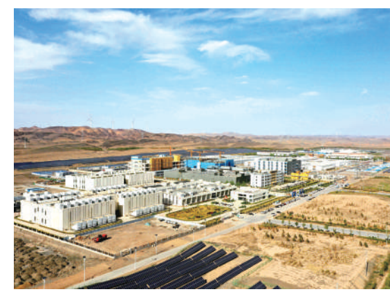
位于中卫市的西部云基地数据中心集群。
