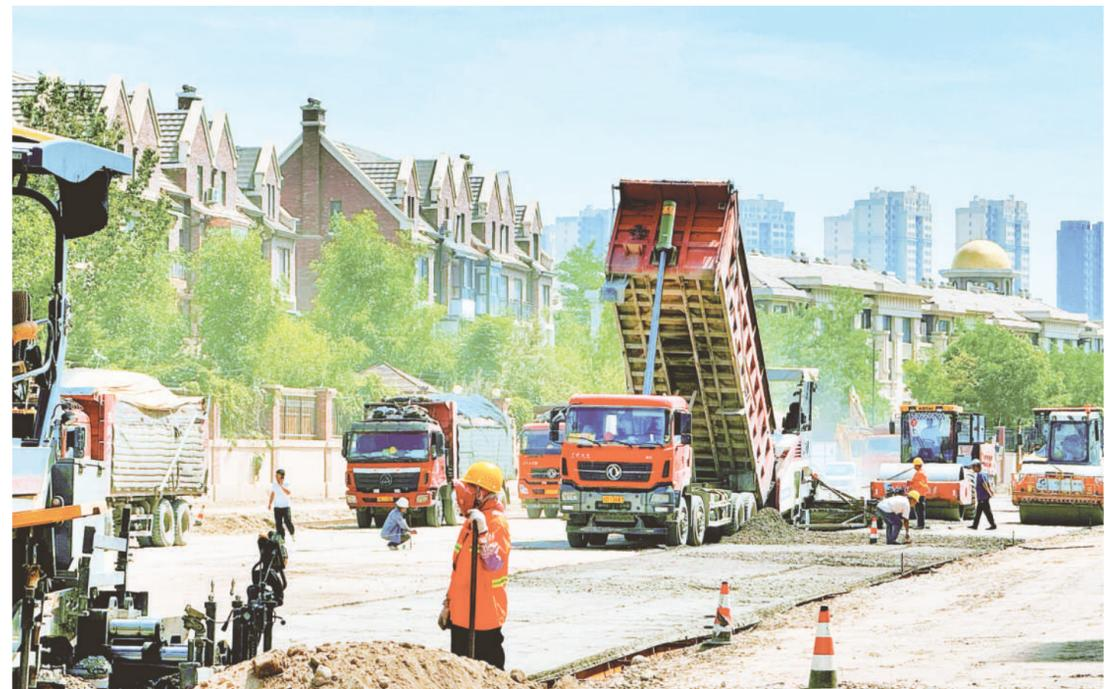
7月13日,银川市兴庆区、贺兰县交界区域积水点改造工程现场,工人正在加紧施工。作为贺兰县城市排水防涝体系建设工程的重要组成部分,该项目西起唐徕渠、东至丽景街,全长4.1公里,项目总投资1.38亿元。 本报记者 马楠 摄
