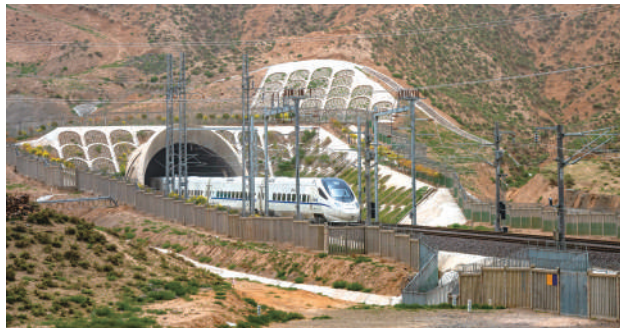
银兰高铁香山隧道。
