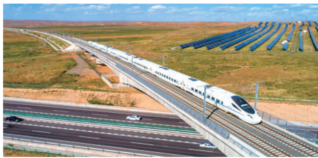
银兰高铁跨滚红高速立交特大桥。
