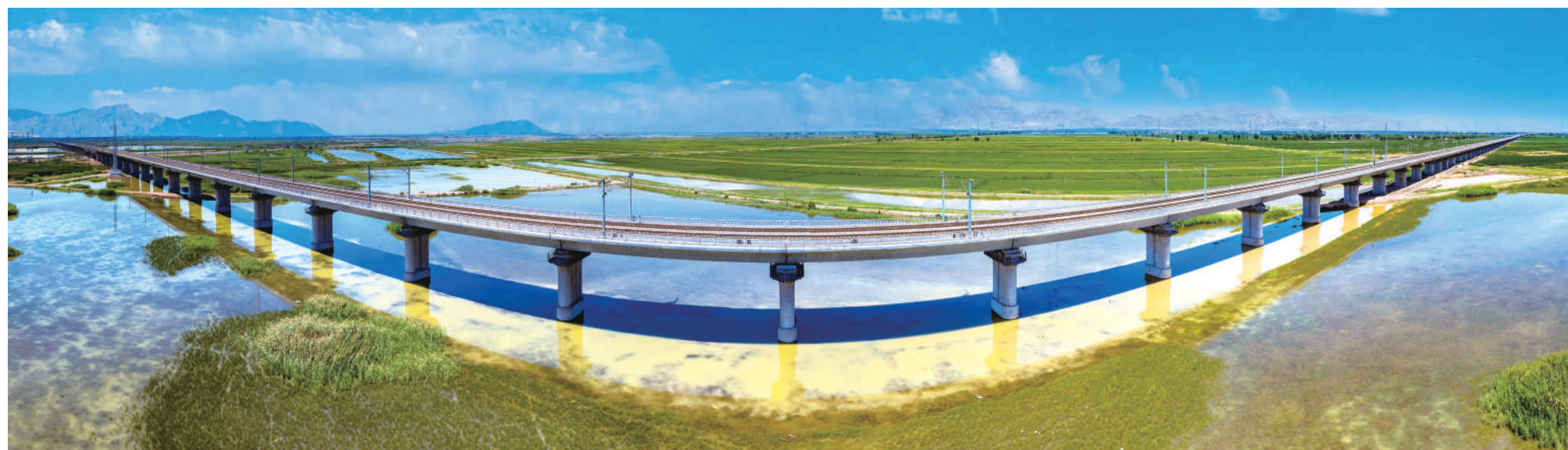
包银高铁石嘴山特大桥。
