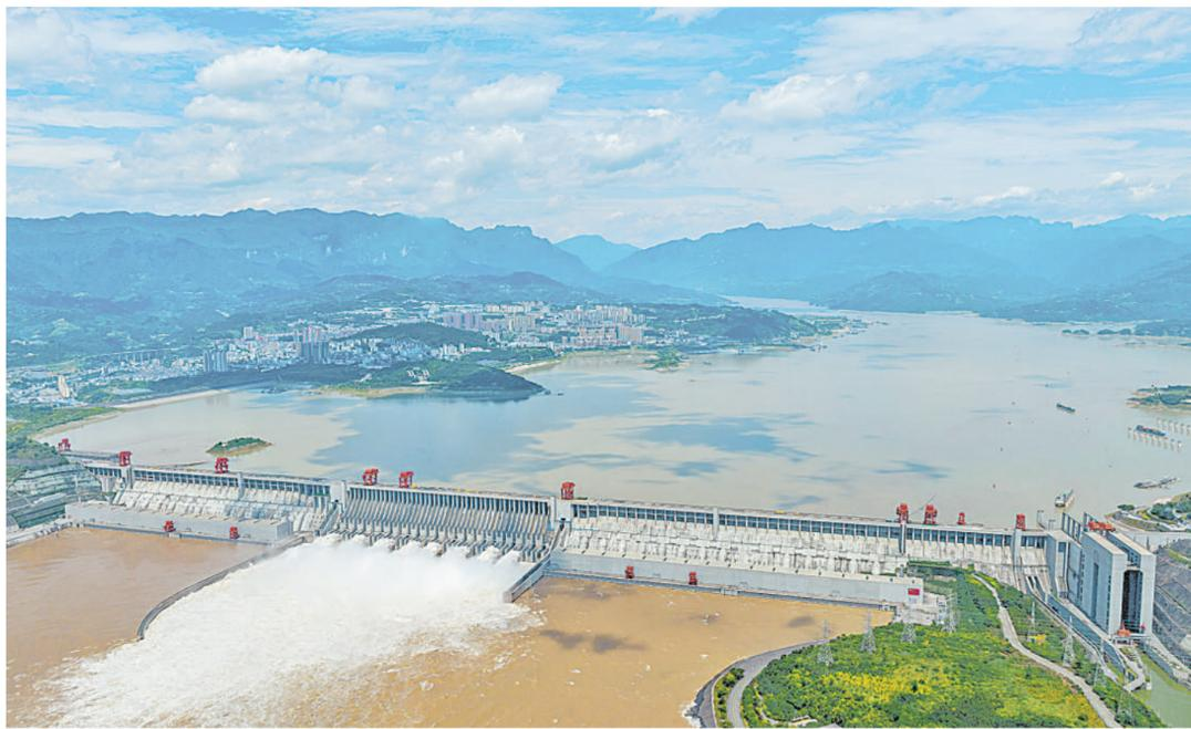
7月18日,三峡枢纽开闸泄洪深孔泄洪(无人机照片)。近日,三峡集团抓住7月中下旬有限的强降雨间歇期,在全力确保中下游防洪安全的前提下,充分利用中下游河道泄流能力,加快降低三峡库水位,做好防汛准备。新华社发
