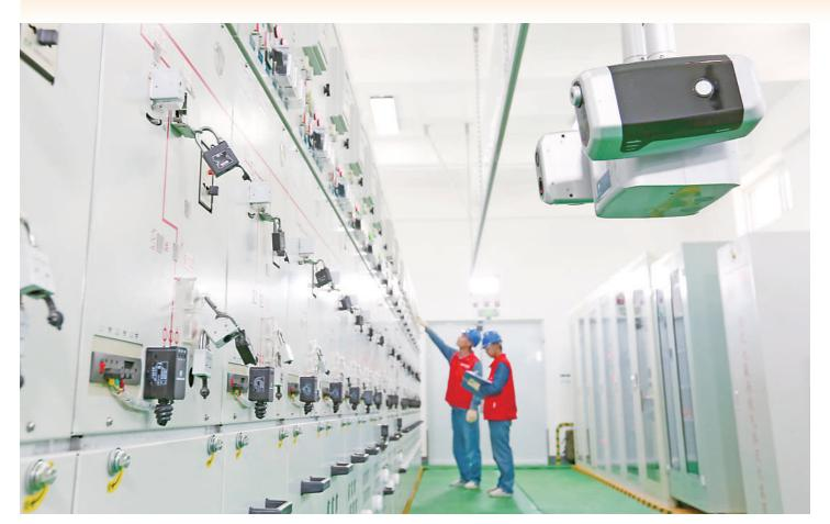
7月17日,在宁夏银川市金凤区新型智慧配电站房,轨道式巡检机器人正在开展自主巡检。当日,宁夏银川市首个"无人巡检"智能配 电站房正式投入使用,标志着银川国家电网数字化配电网综合示范区进入实际运行阶段。传统站房运检模式以人工巡检为主,现场设备 智能化水平低,缺乏有效远程监控手段,站房内环境、安防、消防、视频各类辅助子系统相对独立,存在"信息孤岛",为解决这些问题,国网 银川供电公司在金凤区宁安大街2号开闭所构建了新型智慧配电站房,巡检效率比传统提升41%。
