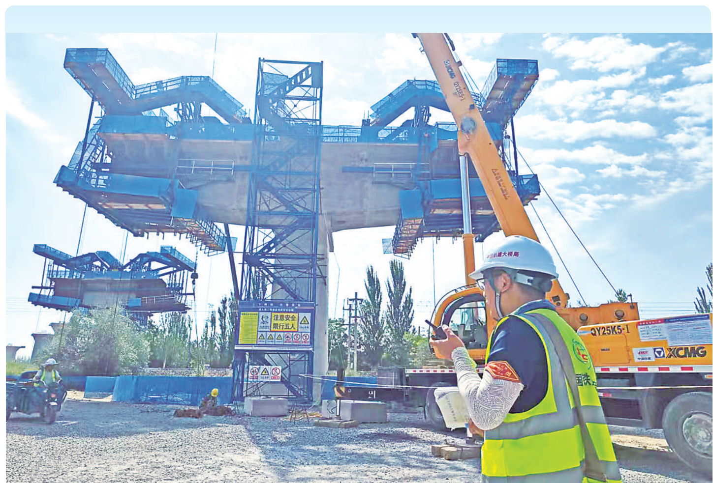
7月23日,防护员李云顶着烈日在施工现场工作。
