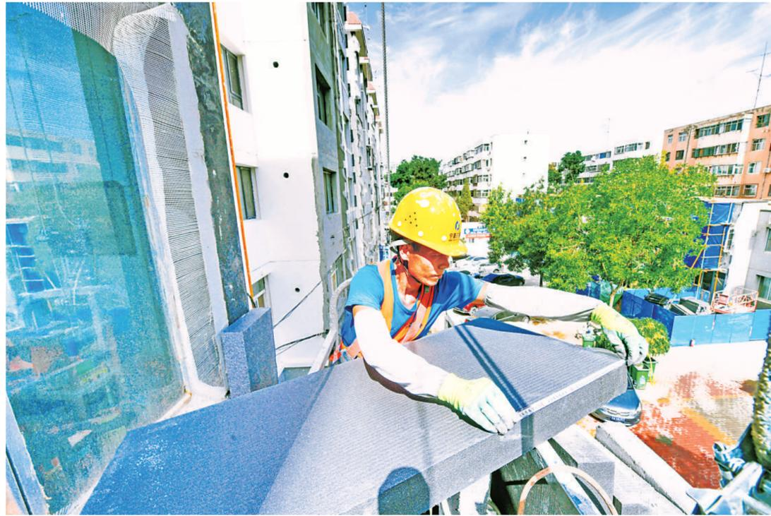
7月23日,工人在更换居民楼外墙保温材料。当日,记者到银川市兴庆区银河家园二区和永康家园南区两处老旧小区改造施工现场探访项目进展。据悉,兴庆区2000年底前建成的老旧小区有723个804万平方米,涉及居住建筑2840栋,11万户26万人,户数占全区的45%、银川市的71%。截至2023年底,已完成改造小区497个626万平方米,涉及居民7.68万户。除列入低效用地、棚户区改造,以及不符合改造政策的自建房、危房外,剩余104个已被列入2024年改造计划,分两批次进行改造。
