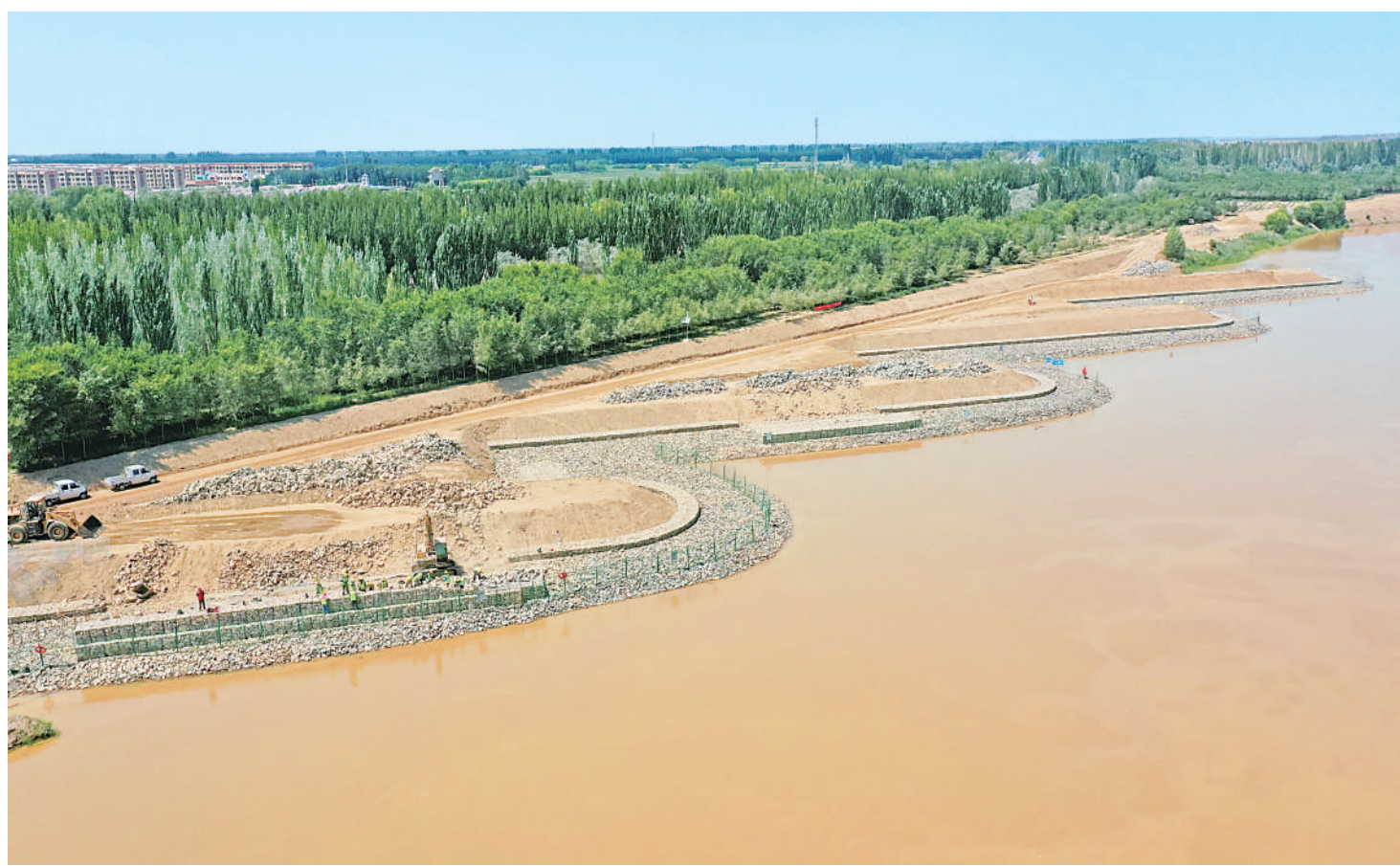
近日,黄河宁夏段河道治理工程(银川片区)仁存渡段抓紧施工。目前,黄河宁夏段河道治理工程各片区建设正酣,向全年目标任务发起冲刺。 本报记者 裴云云 摄
