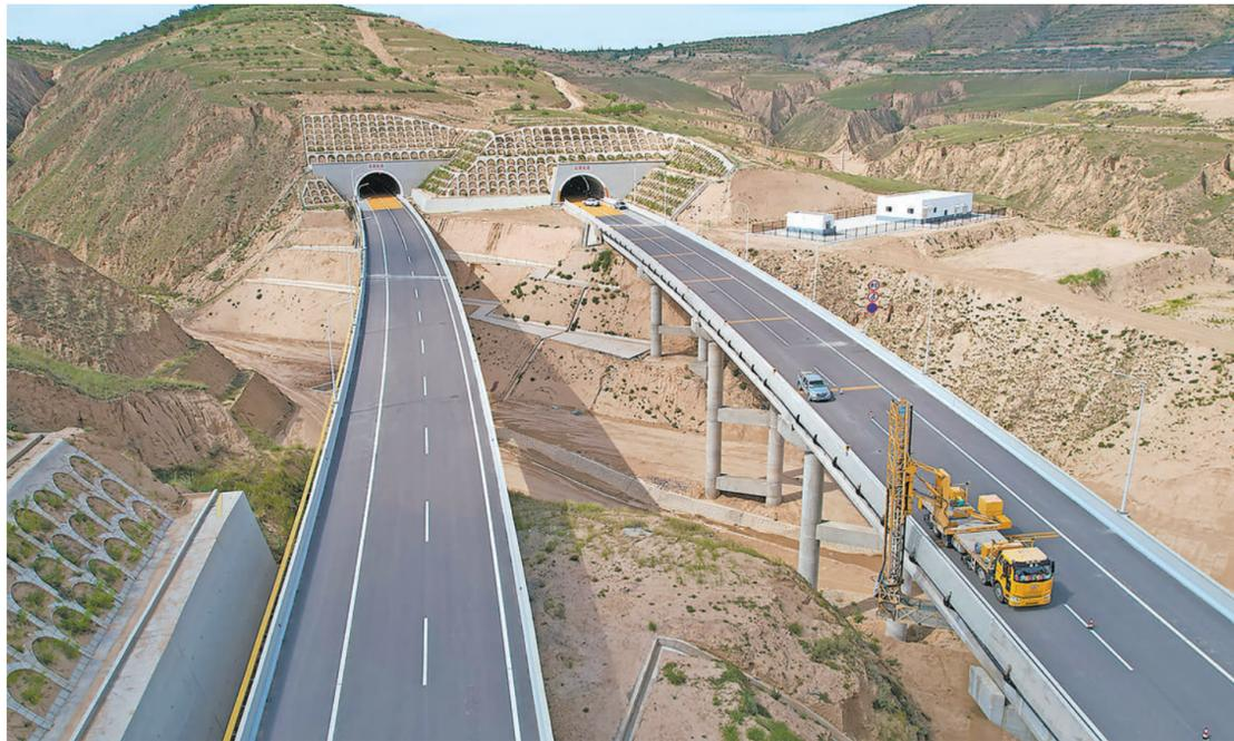
8月1日,中铁十八局承建的银昆高速公路LJ08-1标段南梁隧道及桥梁进行最后的安全检查,为通车做保障。南梁隧道位于中卫市海原县甘城乡境内,采用分离式结构形式,隧道右线全长2295米,左线全长2325米。本报记者 左鸣远 赵磊 摄
