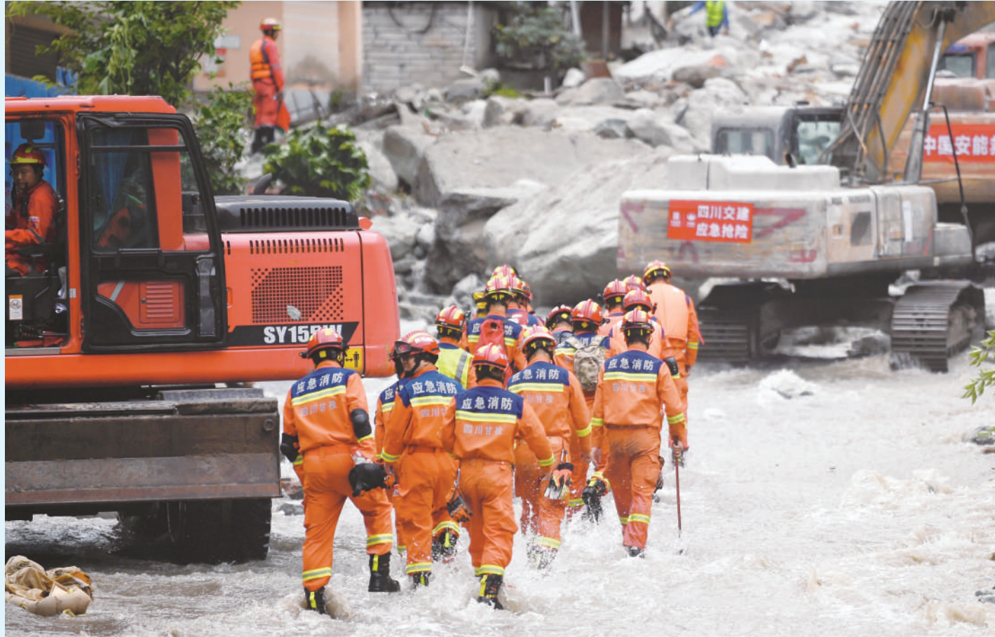
记者从8月4日凌晨在四川省甘孜藏族自治州康定市姑咱镇召开的新闻发布会上获悉,截至3日23时,甘孜康定山洪泥石流灾害已造成4人遇难、23人失联。8月3日3时30分左右,甘孜州康定市姑咱镇日地村突发特大山洪泥石流灾害,致使雅康高速公路康定至泸定段日地1号隧道至2号隧道间桥梁垮塌和姑咱镇日地村房屋被冲毁,造成车辆坠落和人员失联。灾害发生后,当地全力组织搜救,现已累计出动人员1448名,车辆及工程装备215台套,通信设备45台套,救援器材1500余件,搜救犬3只,轻型直升机1架、大型无人机1架。 新华社发
