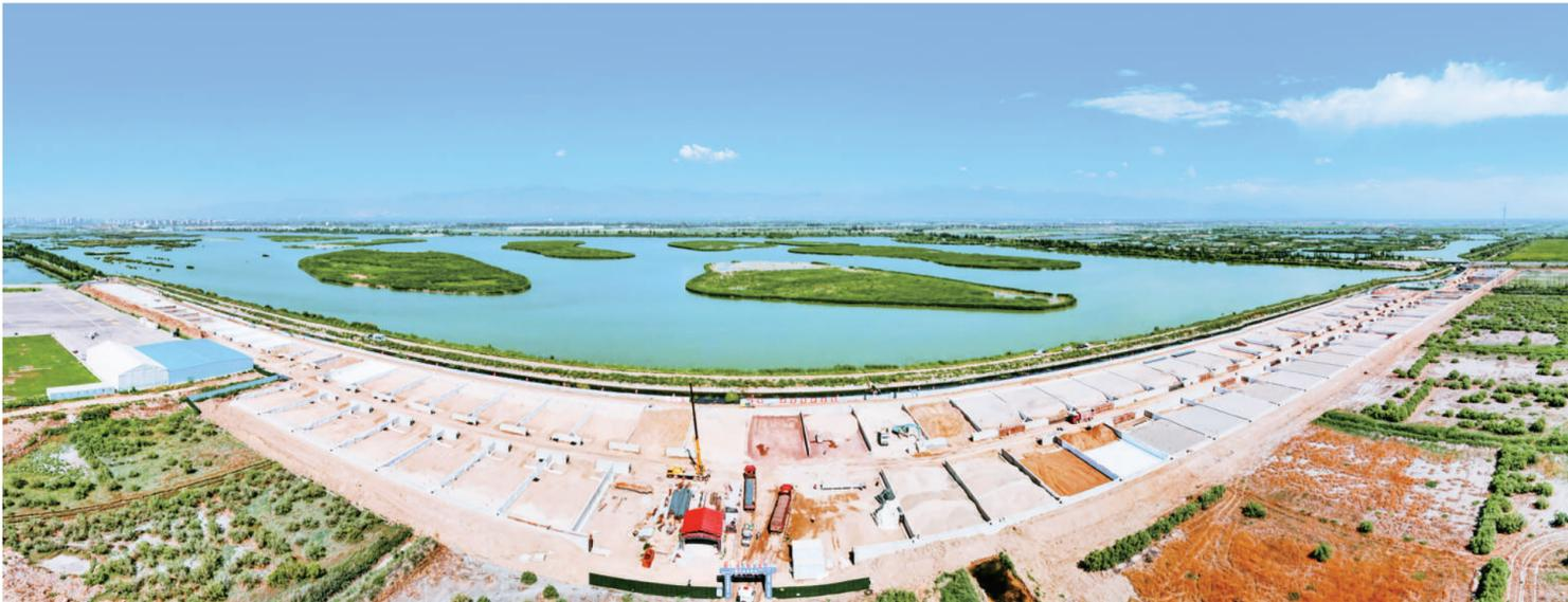
8月5日,银川市第六污水处理厂片区再生水生态利用项目加紧建设。该项目利用银川花博园现有水系湿地,新建或改造为功能性潜流及表流湿地,将第六污水处理厂的尾水通过已建管网排至湿地进行深度净化后用于周边河湖补水、园林绿化及城市杂用。
