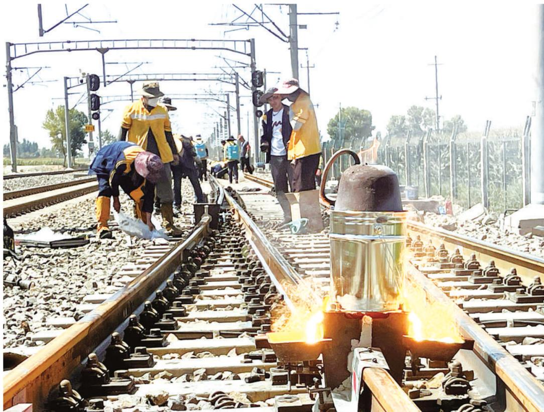
8月5日,银川铁路车间职工在进行钢轨铝热焊接作业。连日来,中国铁路兰州局集团有限公司银川工务段加大管内薄弱线路设备整治力度,全力消除大轨缝、三角坑、轨面不平顺等设备隐患,保障暑运安全。 本报通讯员 苗术儒 摄
