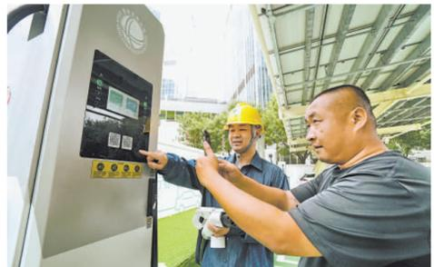
8月11日,在丰台丽泽商务区超级充电站,国网北京市电力公司技术人员指导市民使用超级快充充电桩为汽车充电。近日,国网北京市电力公司首批建设的两家超级充电站在北京投入运营。超级充电站建有400千瓦以上的超级快充主机柜,配备超级快充充电桩以及液冷充电桩,日充电能力最高可达300车次,为电动车主提供更高效率、更快捷的绿色出行充电服务。
