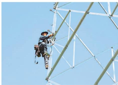
8月13日,固原市清水河至李寨II线接入原州区坪乐110千伏变电站工程施工现场,施工人员对4号铁塔进行检修。这项工程不仅承担着中卫—固原—平凉—庆阳铁路扩能改造及银昆高速公路施工的供电任务,还将满足固原市原州区东北部的用电需求。 本报记者 刘文鑫 摄
