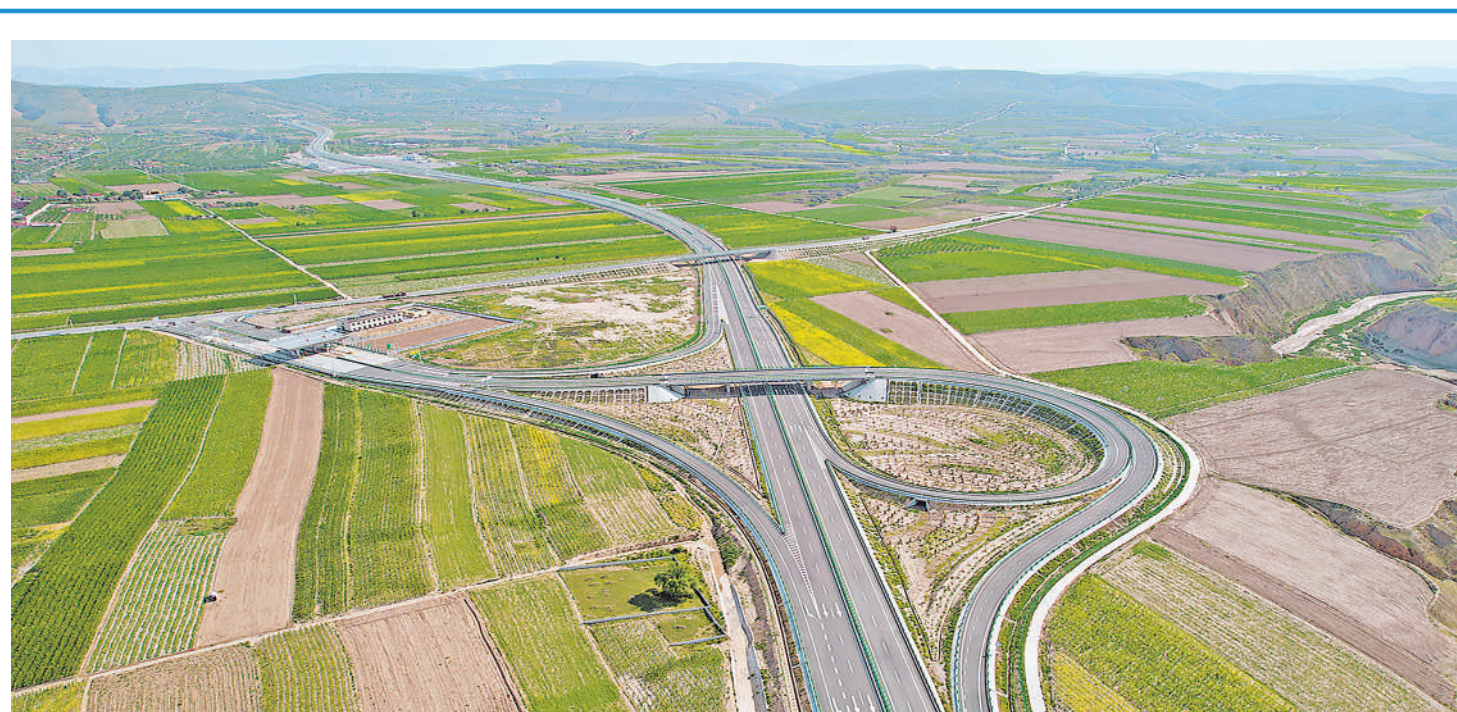
8月16日,银川至昆明高速公路(G85)全线贯通。空中俯瞰中国铁建大桥局承建的甘城互通式立交,与田野交织出一幅壮美画卷。本报记者 左鸣远 摄
