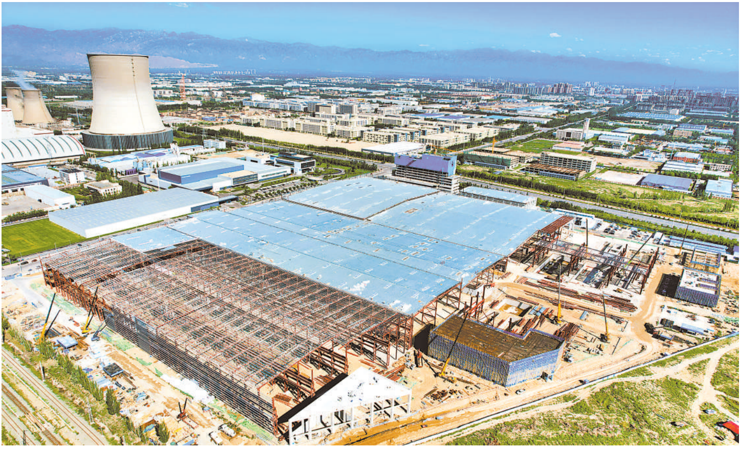
8月19日,银川威力传动技术股份有限公司投资50亿元的风电增速器智慧工厂项目建设现场,数十台大型工程机械齐上阵,项目进度加速推进。据了解,该项目位于银川经济技术开发区,总用地面积309.54亩,建筑面积17万余平方米。项目建成投产后预计实现年产4000台风电增速器的能力,可新增就业岗位1800个。
