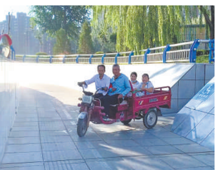
无障碍通道对面是非机动车道的墙面,存在视觉死角。
