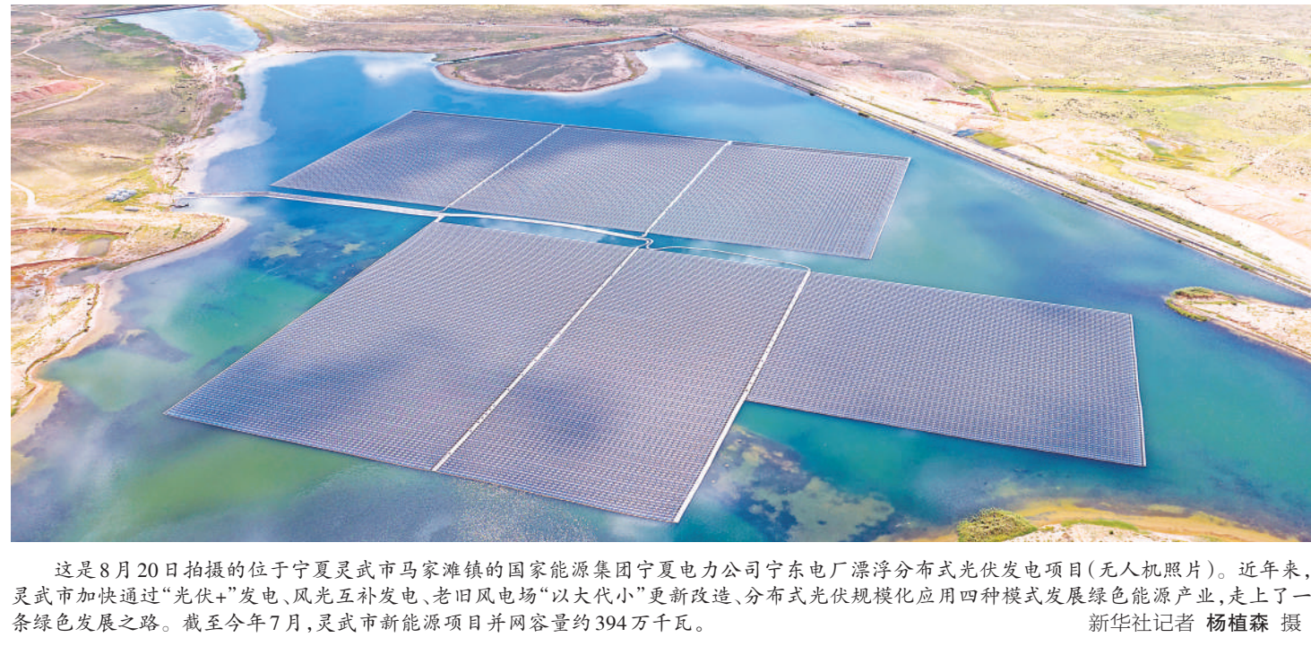
这是8月20日拍摄的位于宁夏灵武市马家滩镇的国家能源集团宁夏电力公司宁东电厂漂浮式光伏发电项目(无人照照片)。近年来,灵武市加快通过“光伏+”发电、风光互补发电、老旧风电场“以大代小”更新改造、分布式光伏规模化应用四种模式发展绿色能源产业,走上了一条绿色发展之路。截至今年7月,灵武市新能源项目并网容量约394万千瓦。
