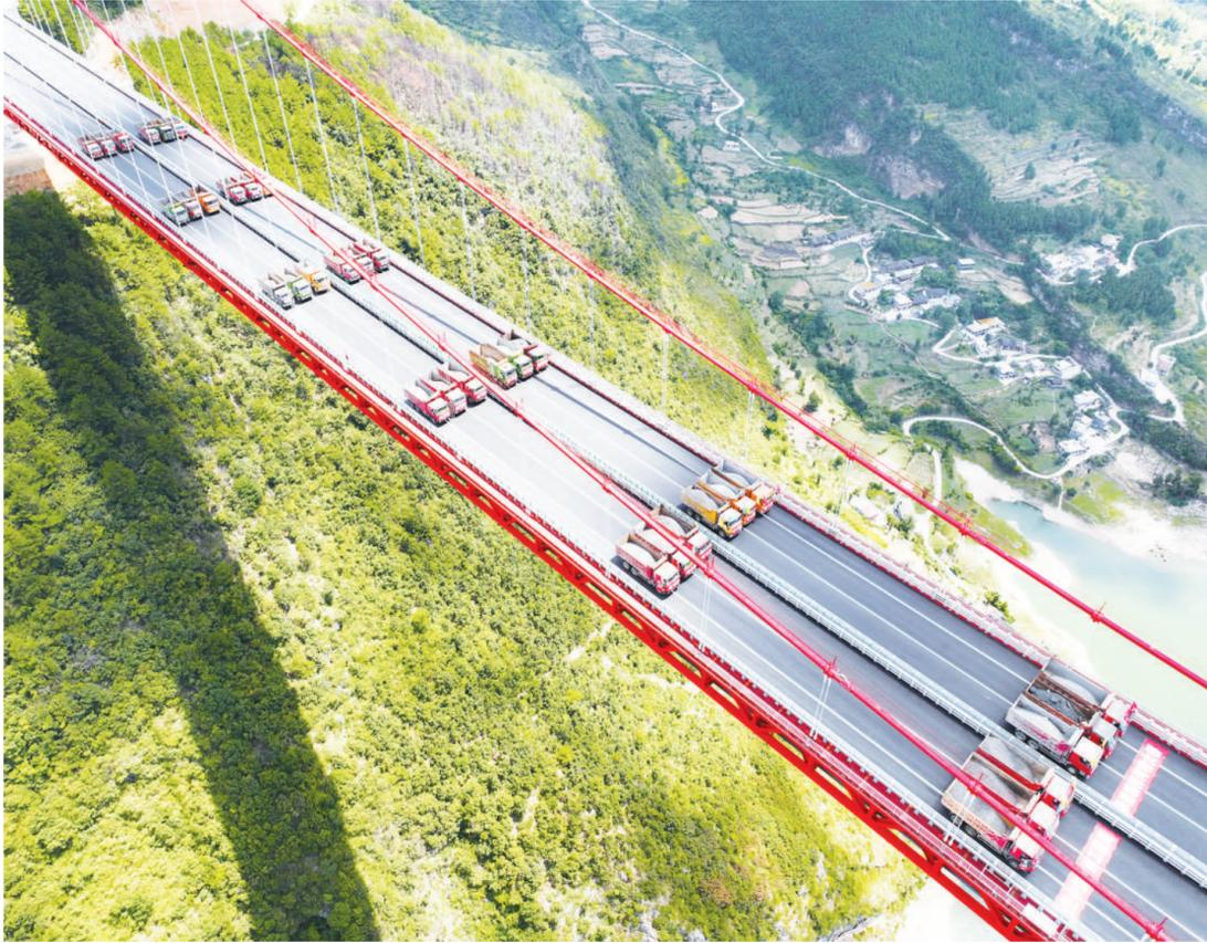
8月24日,大货车停放在桐梓河特大桥上进行荷载试验(无人机照片)。当日,由中铁广州局承建的贵州金(金沙)仁(仁怀)桐(桐梓)高速桐梓河特大桥开始进行荷载试验,数十辆大货车按照精密设计的方案停放在特定位置,模拟板端荷载下的桥梁状态,全面评估桥梁工作性能,确保其安全无虞。该桥位于贵州省仁怀市、桐梓县交界处,横跨桐梓河,全长1422米,主跨达965米,主塔高208米,是全线重要的控制性工程。新华社发
