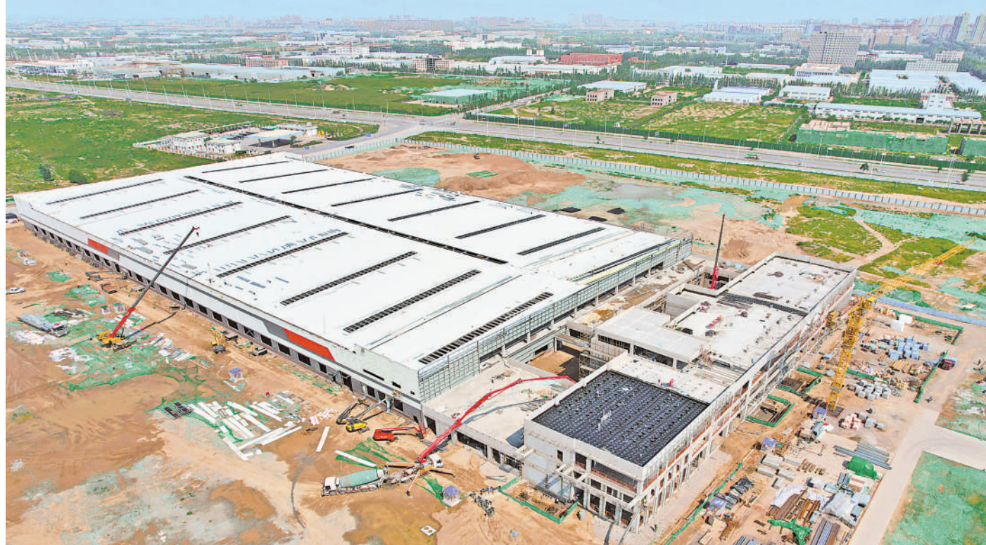
8月29日，高端装备智能制造产业园项目建设现场。该项目选址银川经济技术开发区，计划总投资11.4亿元。目前，项目一期建设进度已超75%，预计今年10月交付使用。本报记者 马楠 王洋 摄
