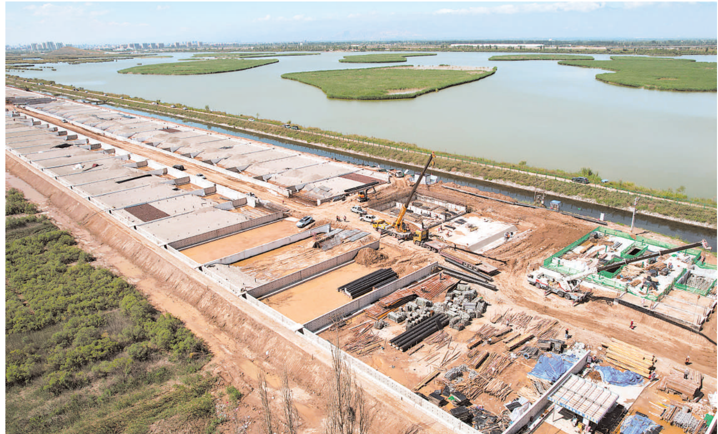
8月28日,位于中国(银川)花卉博览园北侧的银川市第六污水处理厂片区河湖生态再生水利用工程项目建设稳步推进。该项目概算总投资7996.4万元,主体工程计划9月底完工。项目建成后,将大幅提高再生水综合利用率。 本报记者 左鸣远 马赛尔 摄
