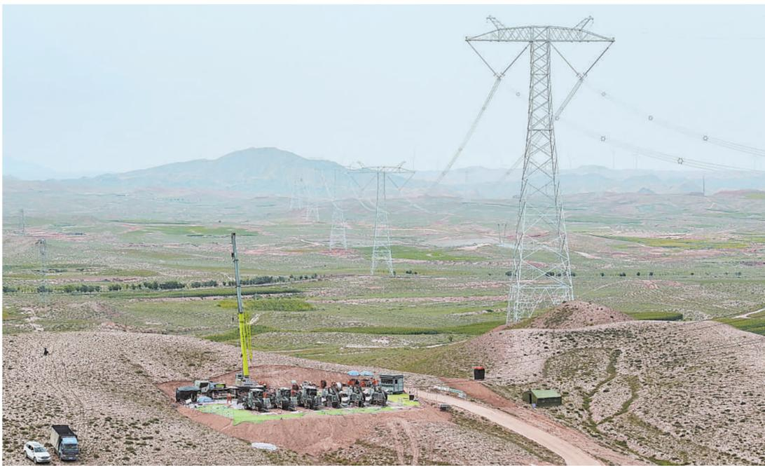
图为9月9日拍摄的宁夏至湖南±800千伏特高压直流输电工程(宁夏段)架线施工现场。目前,该工程本体线路基础施工已完成491基,铁塔组立完成447基,导线架线完成65.092公里;接地线线路基础施工完成288基,铁塔组立完成258基,导线架线完成18公里,已全面进入架线施工阶段。
