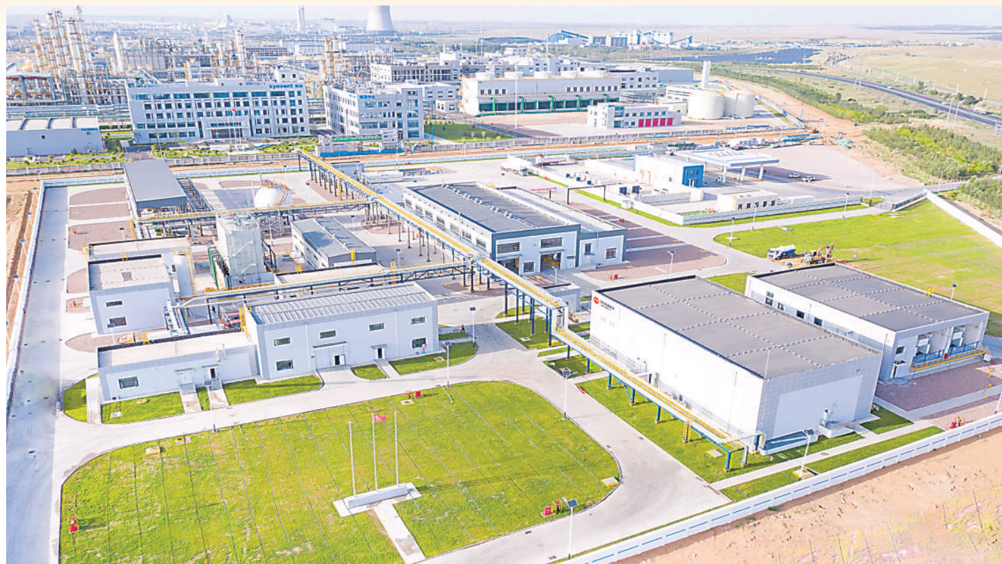
国华投资(氢能公司)永利制氢厂。永利制氢厂与永利综合能源站配套形成国内首个重载交通专供“绿氢制加一体化”项目。截至目前,永利综合能源站已为氢能重卡加注氢气55.6吨,氢能重卡累计运营62万公里,减排二氧化碳约651吨。(受访者供图)
