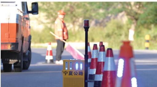
采用现代物联网技术的移动智能雷达锥桶,提升公路养护工程施工的安全主动防护能力和安全智慧管理水平。
