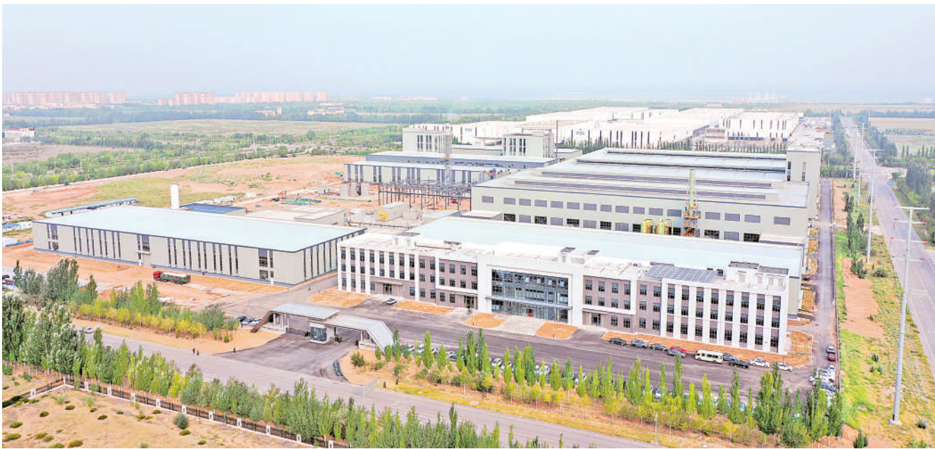
近日,苏银产业园宏基新材料(宁夏)有限公司特种石墨项目正式投产,为银川市新材料产业链补上关键一环。该项目一期计划总投资21亿元,建筑面积27万平方米,建设年产5.3万吨特种石墨生产线,全部建成后可实现年产值34亿元,年纳税5.5亿元。
