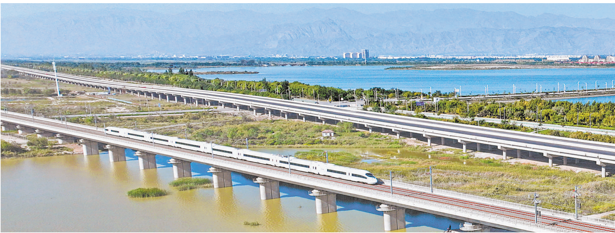
10月1日,包银高铁惠农至银川段正式开通运营,与银西高铁、银兰高铁实现大贯通,石嘴山市接入全国高铁网。包银高铁惠银段是我国“八纵八横”高铁网北京至兰州通道的组成部分,线路全长97公里,设计时速250公里。 本报记者 王猛 马楠 白茹 李宏亮 摄
