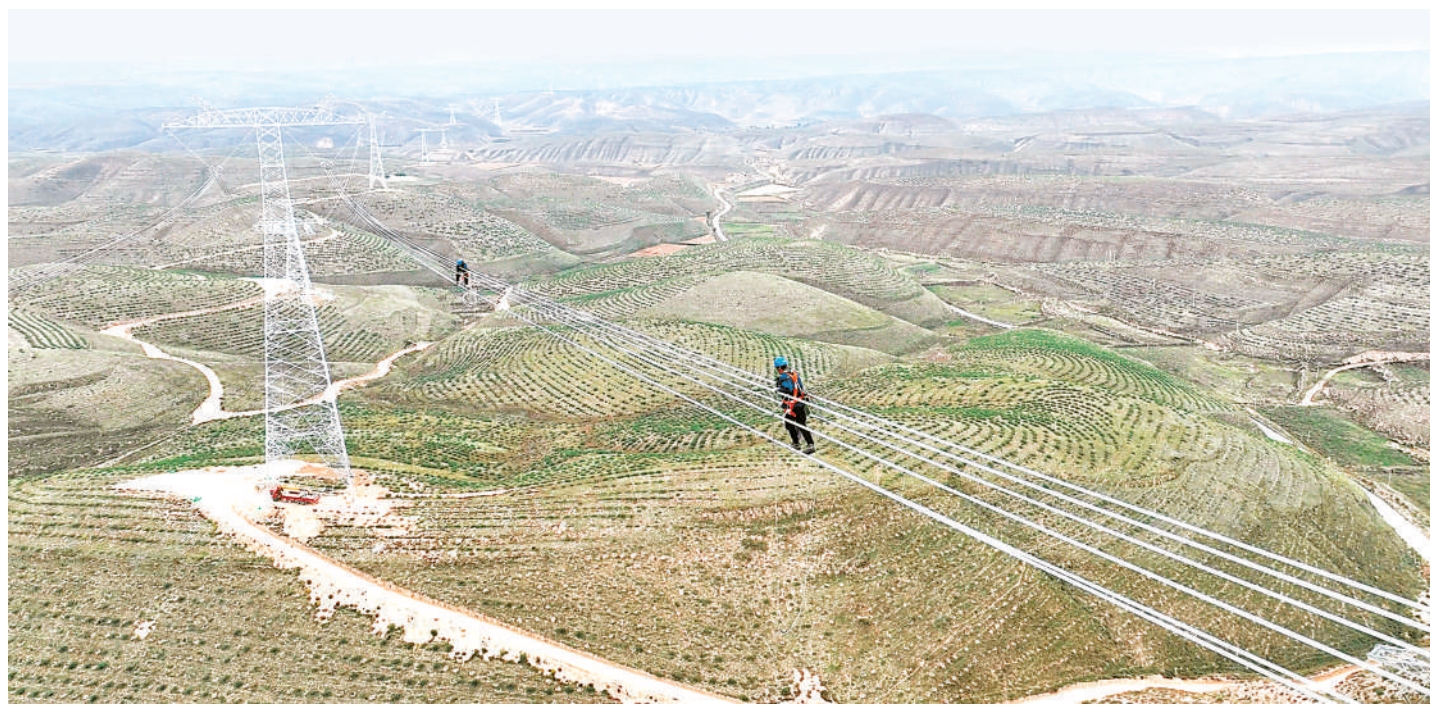
近日,宁夏至湖南的±800千伏特高压直流输电线路工程(宁夏段)完成区内首跨±800千伏天中中线的施工任务,为全线顺利贯通奠定了基础。 本报记者 鲁延宏 摄
