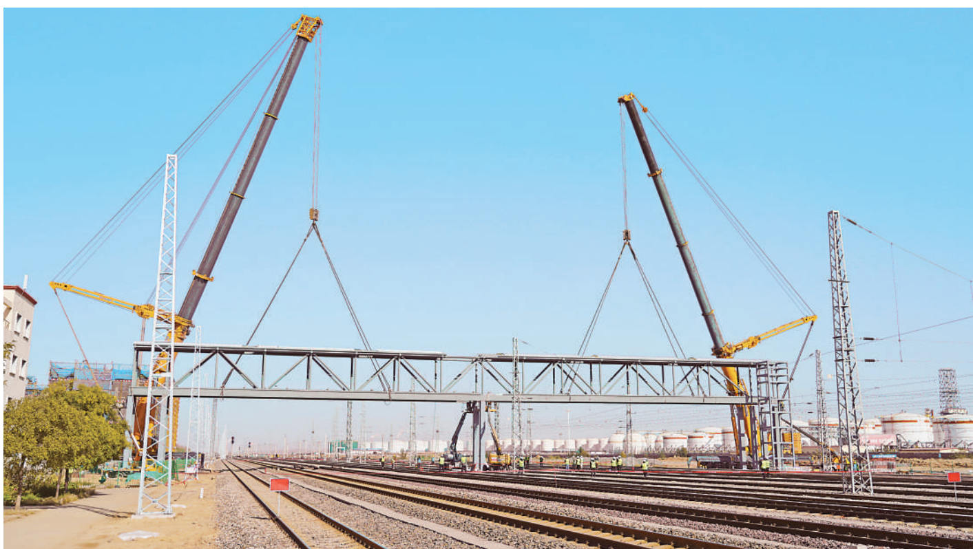
10月10日,我区单体最大全钢跨铁路人行天桥在西部创业宁东铁路鸳鸯湖基地完成吊装和一次性焊接贯通。本报记者 李峰 摄
