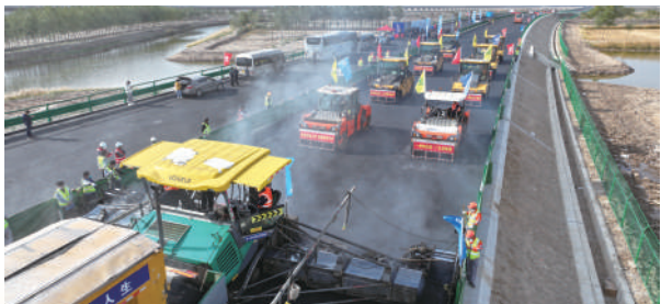
乌玛高速公路石嘴山段已利用工业固废265万吨,减少碳排放量约7500吨。
