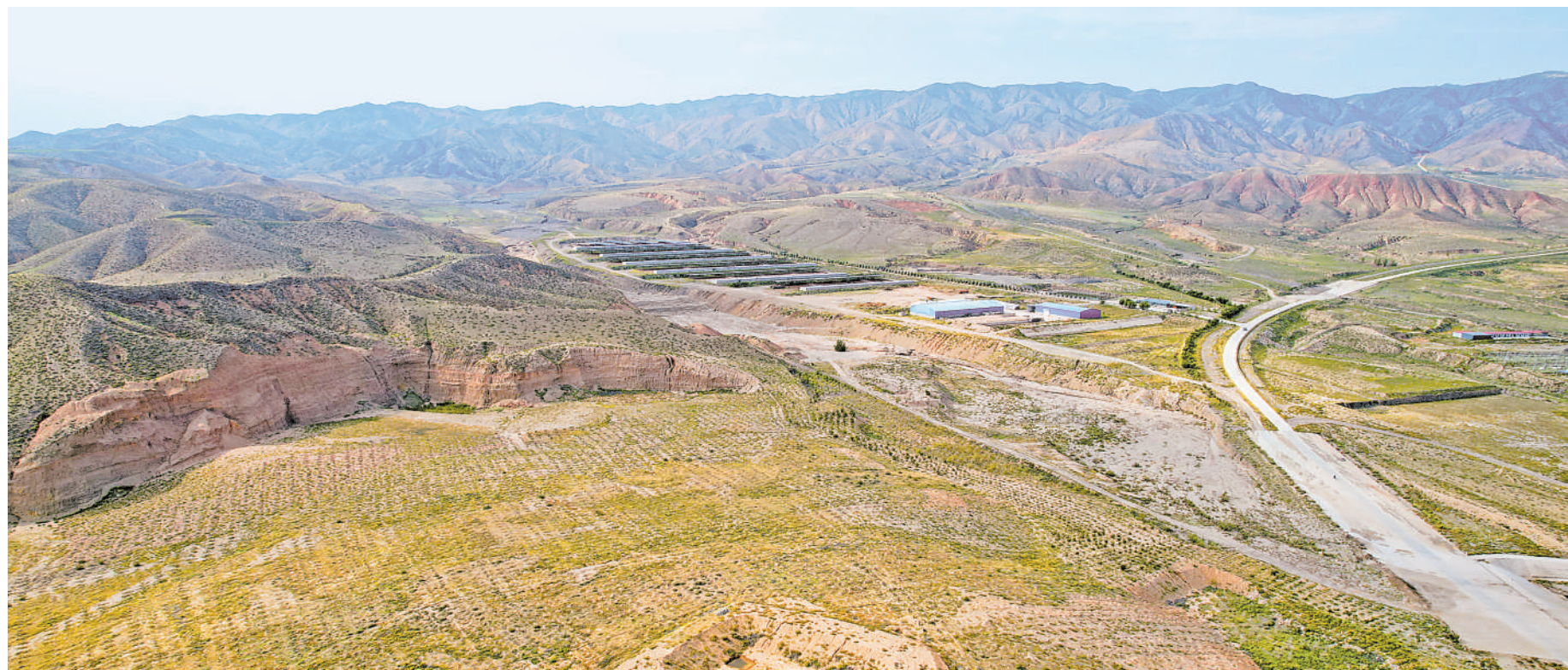
沙坡头区常乐镇历史遗留矿山生态保护与修复综合治理项目,通过实施对地形地貌重塑、覆土、植被恢复、养护等措施进行生态修复。
