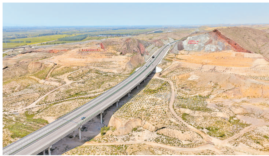
沙坡头区涩井沟历史遗留矿山形成的巨坑已经被填平,大地“伤疤”得以修复。
