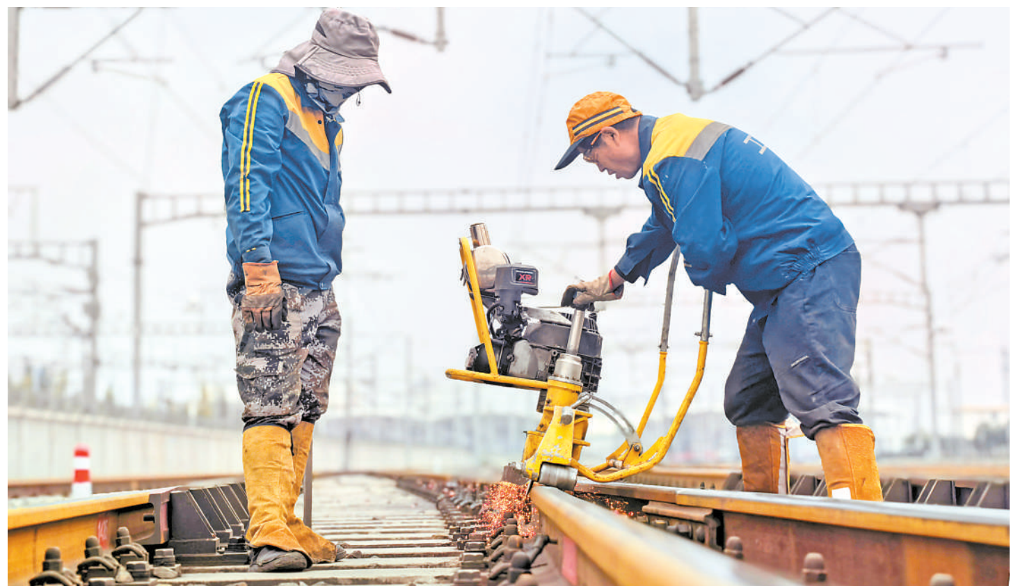
10月16日,银川线路车间职工在银川站进行钢轨肥边打磨。连日来,中国铁路兰州局集团有限公司银川工务段狠抓设备秋检安全,加大管内列车径路、道岔咽喉和重点薄弱线路设备的检查整修力度,全力确保运输安全。 本报通讯员 苗木儒 摄
