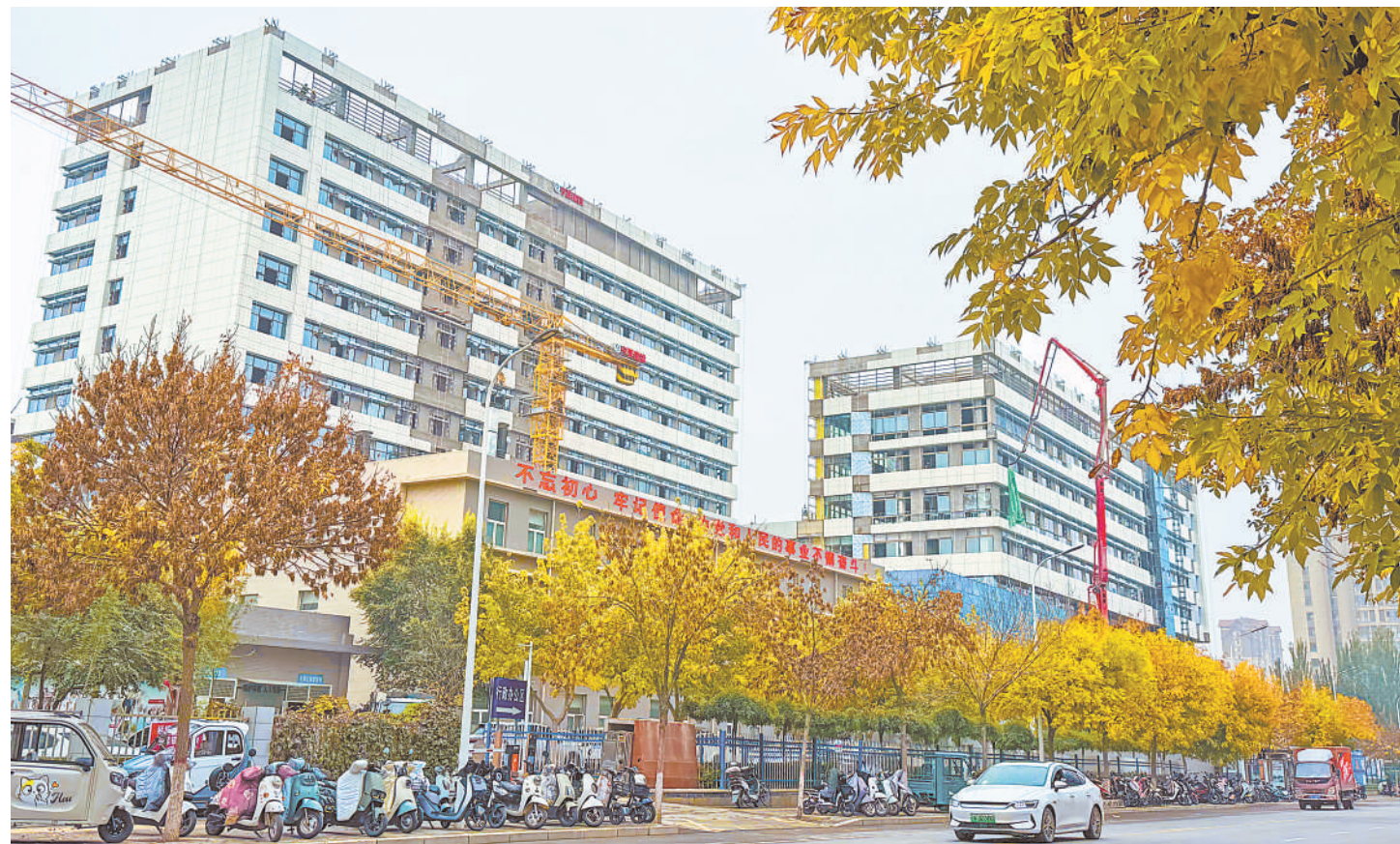
10月17日,国家妇女儿童区域医疗中心暨北京大学第一医院宁夏妇女儿童医院项目建设现场,工人与工程机械配合进行外立面装饰装修施工。该项目是宁夏首个国家区域医疗中心,项目建成后将有效推动优质医疗资源的延伸。
