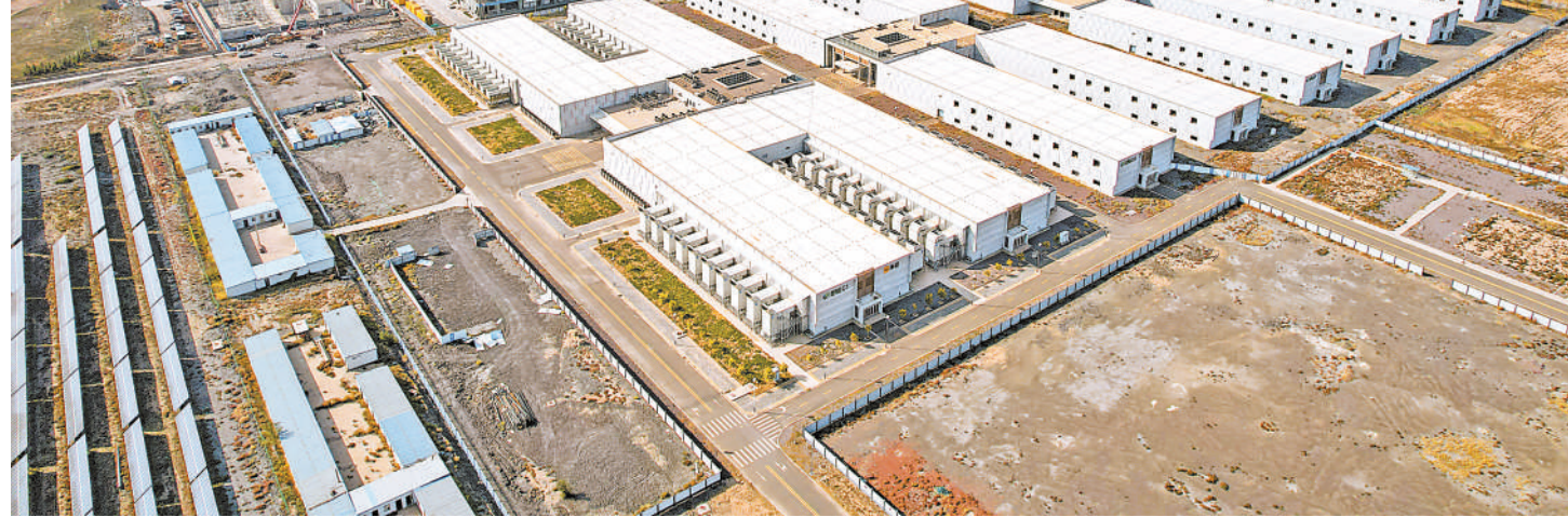
10月16日,俯瞰中卫市沙坡头区西部云基地,一栋栋数据楼拔地而起,见证这里从“荒漠戈壁”到“沙漠硅谷”的变化。我区抢抓国家“东数西算”重大机遇,加快数据中心重大项目建设,算力基础设施建设呈现快速发展态势,建成大型、超大型数据中心9个,在建数据中心项目18个。
