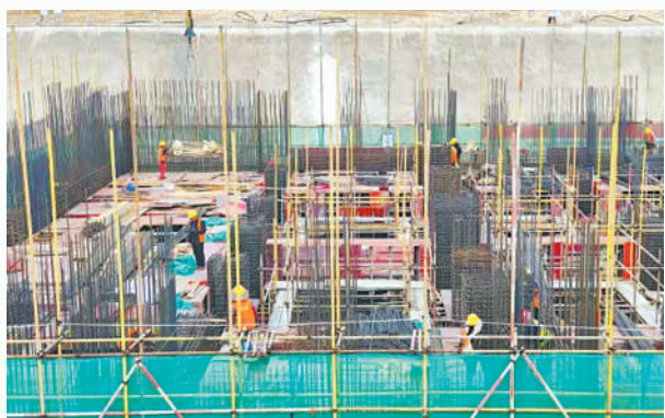
施工人员抢抓工期加快建设。
