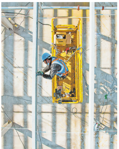
↑工人正在安装电气设备。
