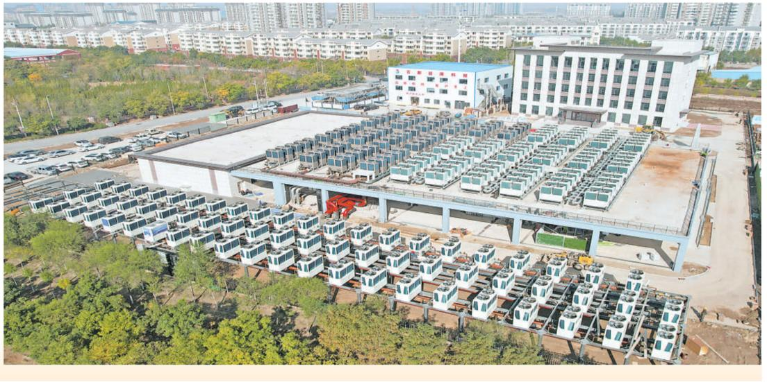
10月25日,宁夏百新能源科技发展有限公司银川北部热源厂二期项目建设的135台空气源热泵和4台水源热泵机组,进入最后的联机调试阶段。
