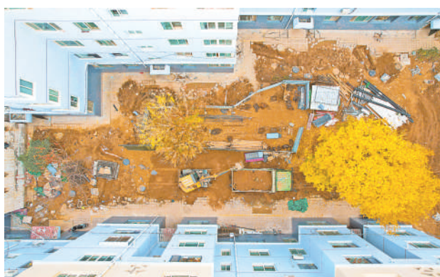
10月30日,银川市金凤区区长城中路街道南湖苑小区老旧小区改造工程已完成主体改造,目前进入地面施工收尾阶段。今年,金凤区计划改造老旧小区28个,改造面积约57.92万平方米,涉及178栋楼6976户。 本报记者 马楠 王洋 摄
