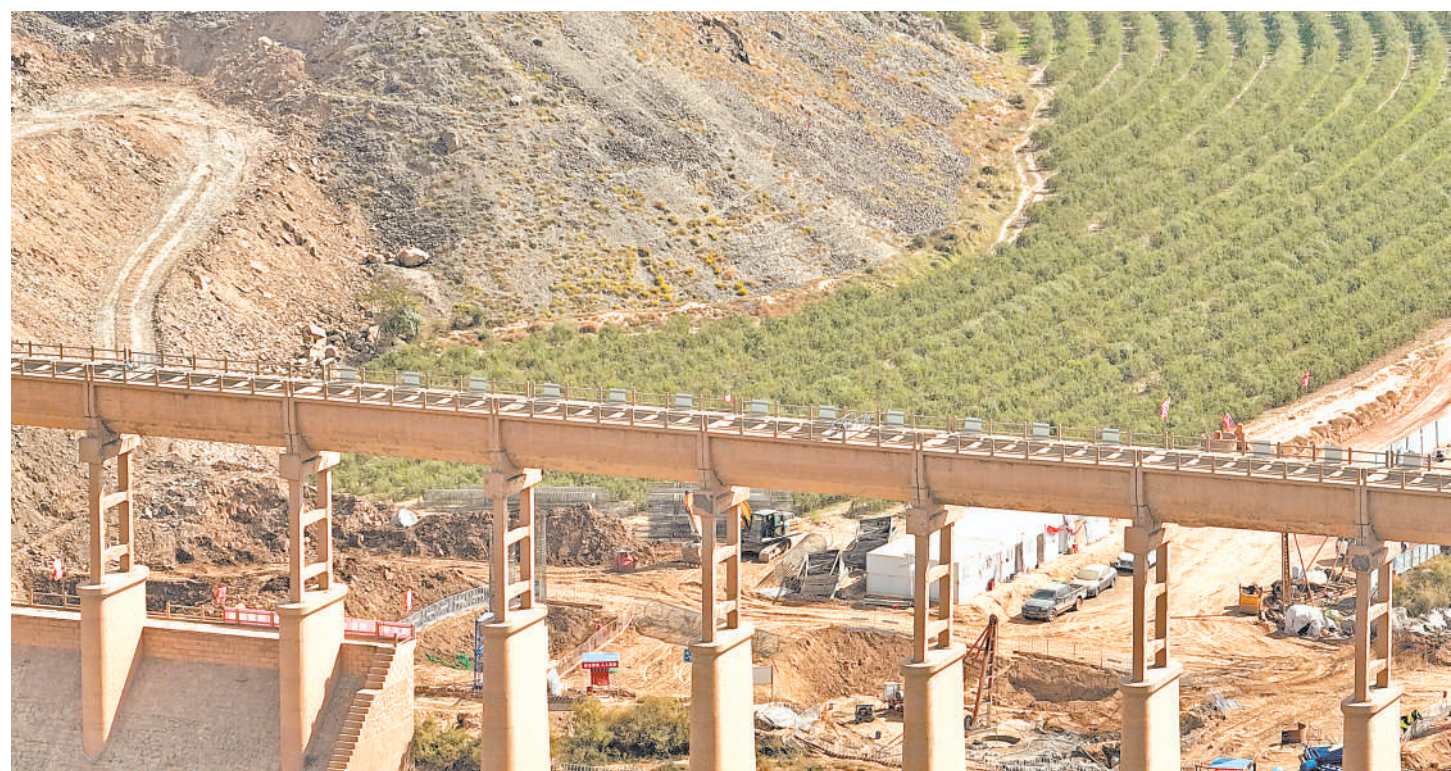
近日,宁夏最长渡槽——固海扬水工程之长山头大渡槽更新改造项目启动。此次更新改造工程总投资6558万元,预计工期11个月,项目完成后,将进一步提升固海扬水工程服务宁夏中部干旱带的能力。
