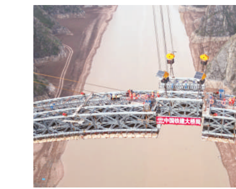
11月2日,中国铁建大桥局工人在兰合铁路洮河大桥上吊装拱肋拱架(无人机照片)。 当日,兰合铁路洮河大桥主拱顺利合龙,为兰合铁路(兰州至合作)按时通车奠定了坚实基础。 洮河大桥位于甘肃省临夏州永靖县与东乡县洮河峡谷区,是兰合铁路全线重难点工程,桥梁全长430.5米,主桥为跨径220米的上承式劲性骨架钢筋混凝土拱桥。 兰合铁路新建正线全长147.42公里,设计时速200公里。兰合铁路建成通车后,甘肃省临夏、甘南两州将结束不通铁路的历史。 新华社发
