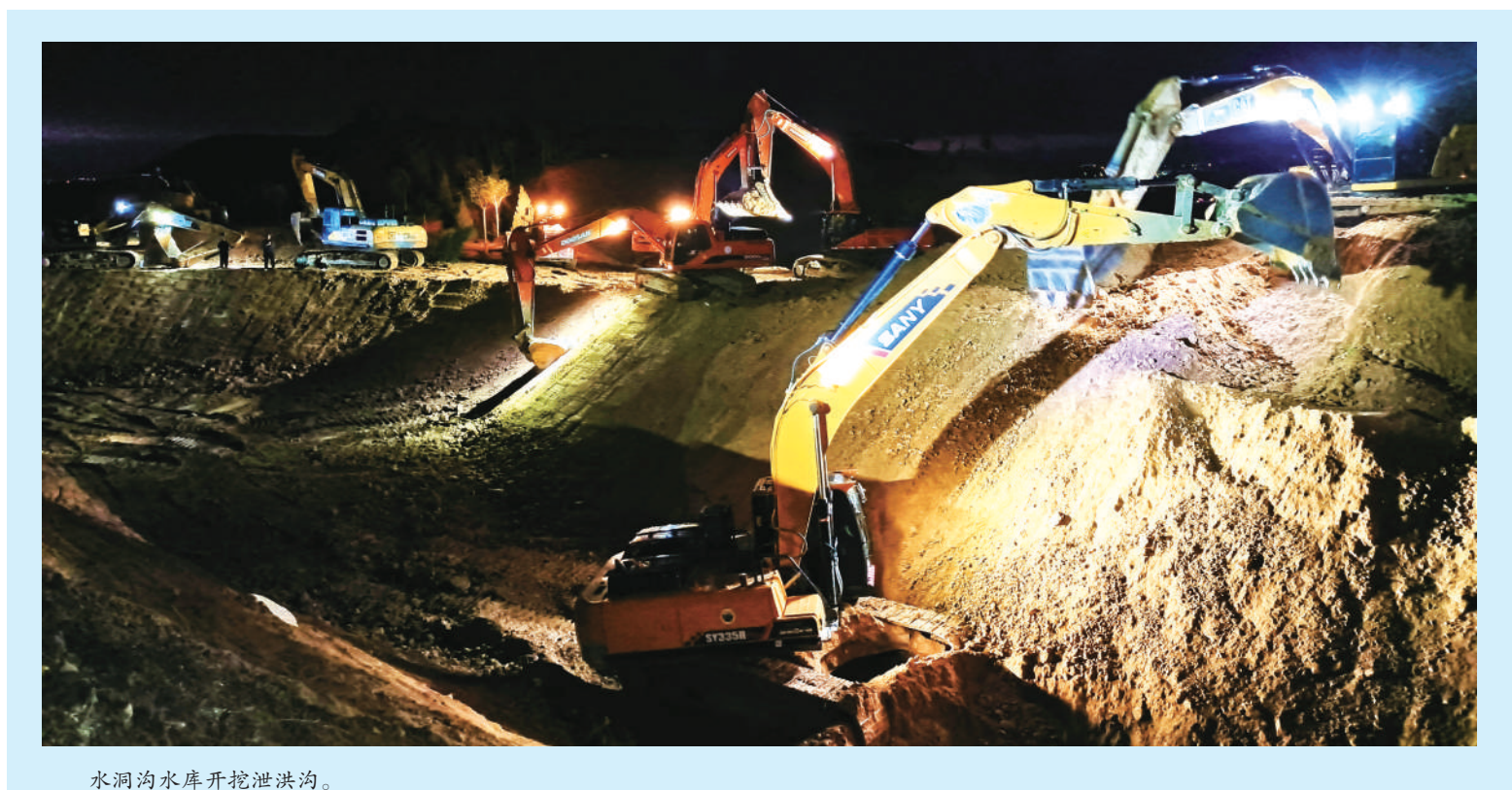
水洞沟水库开挖泄洪沟。
