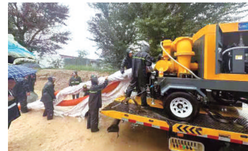
应急救援人员在银川市西夏区镇北堡镇华西村居民区内涝点抢险。
