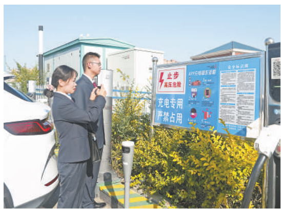
银川市兴庆区检察院运用“充电桩设施安全生产隐患排查”法律监督模型“碰撞”出40余个疑似问题,检察官实地核实。 本报记者 杨超 摄
