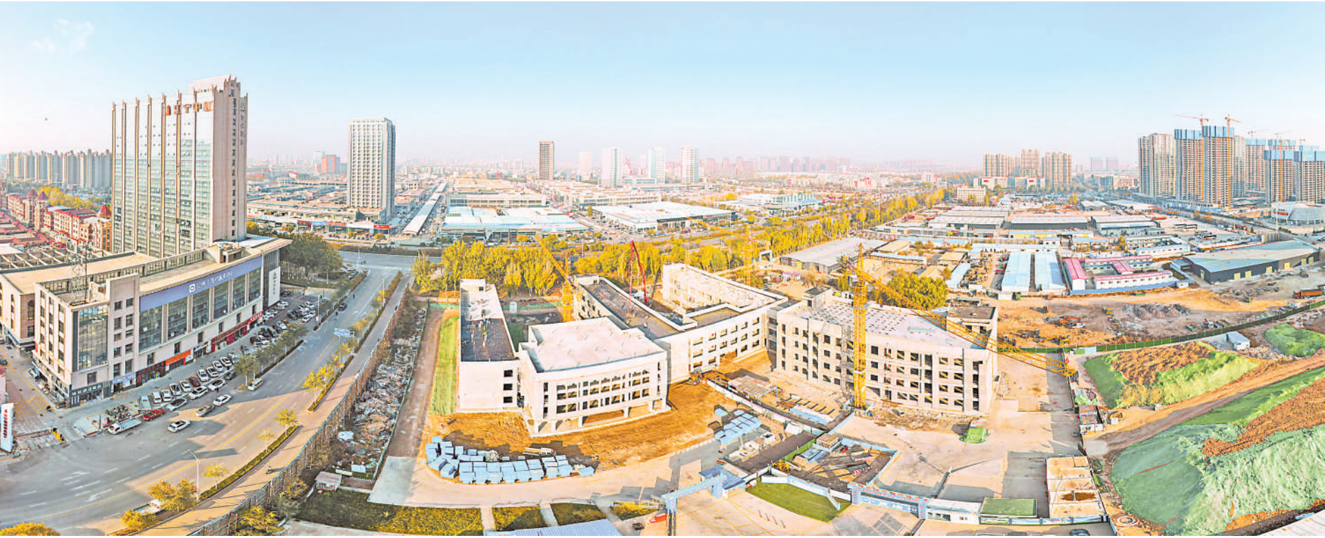
11月10日,银川市兴庆区第三十五小学新建项目建设现场。该项目位于兴庆区丽景北街东侧、宁港南巷北侧,总建筑面积12648.27平方米。目前项目主体已经封顶,正在对内外面进行装修,建成后解决该区域周边宁港城、恒大帝景等小区适龄学生的就近入学问题。
