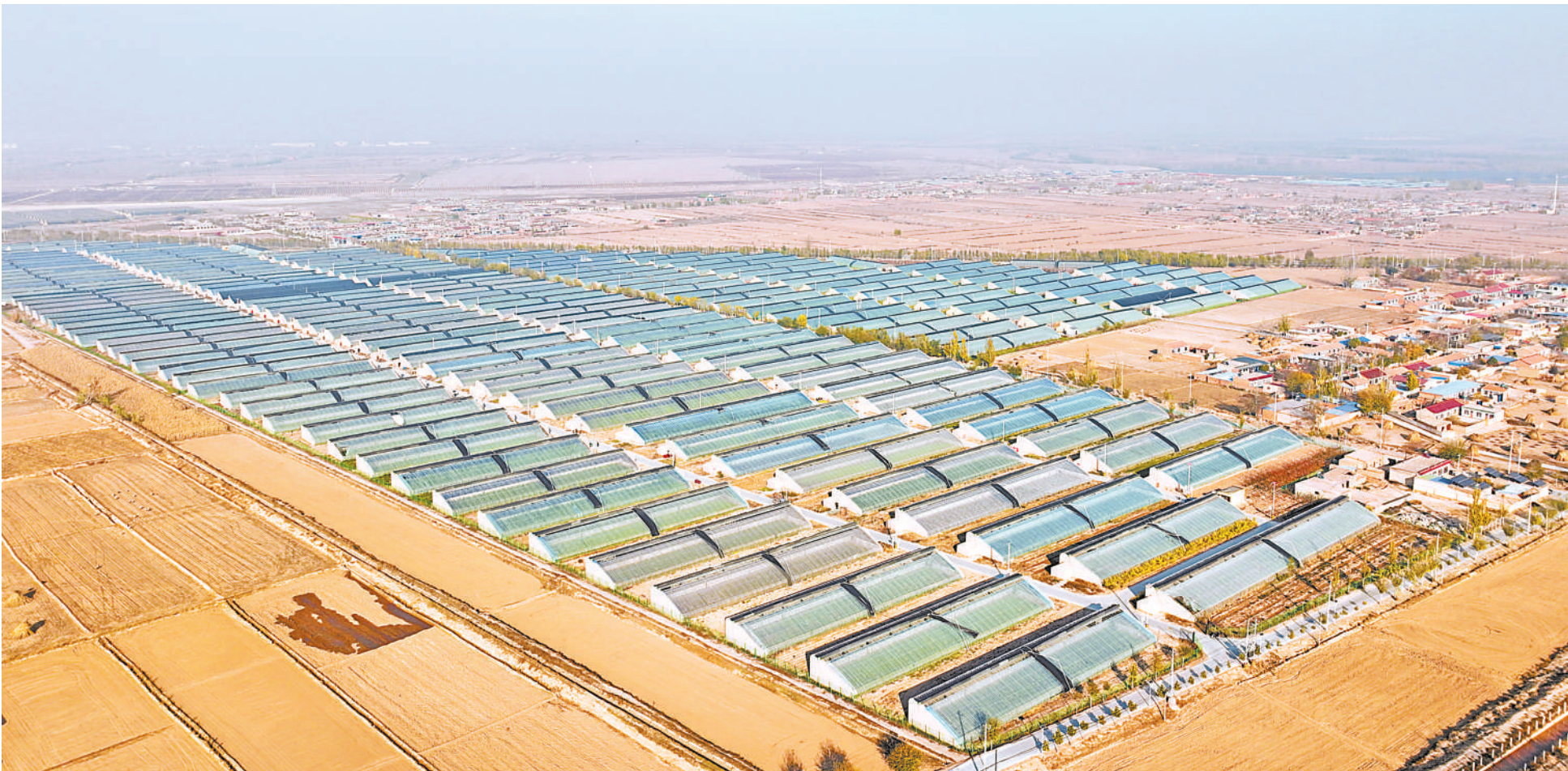
11月7日,俯瞰永宁县闽宁镇园艺村农业设施大棚基地,与生态移民村构成了一幅美丽的乡村图景。该基地占地面积673亩,采用新型钢架和保温材料,目前已建成农业设施大棚182栋,项目总投资5830万元,形成集果蔬及观光采摘等于一体的特色产业,助力农民增收。
