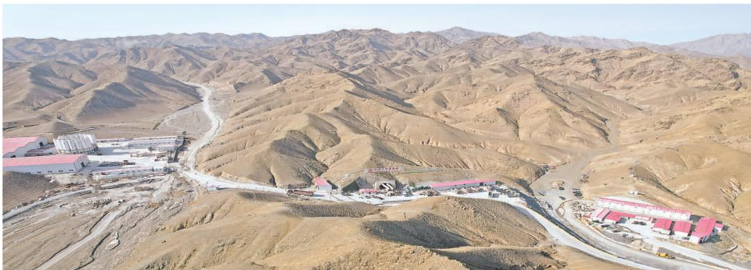
11月11日,由中铁十五局承建的包银高铁银巴支线铁路贺兰山隧道安全掘进6670米,成功到达宁夏分界里程,贺兰山隧道预计2025年3月底全线贯通。 本报记者 左鸣远 摄
