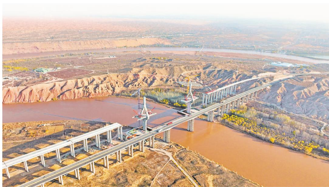
11月10日,中卫黑山峡黄河大桥工程项目正在加速建设。大桥全长1539米,主跨240米,建成后有效缓解国道338线通行压力,成为连接兰州西宁市群和宁夏沿黄城市带的重要通道。
