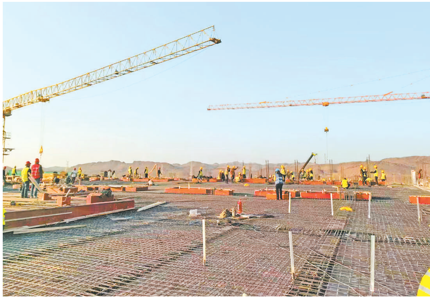
11月14日,中国联通宁夏中卫云数据中心项目建设现场。
