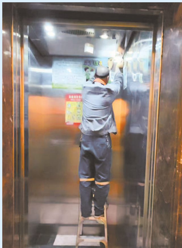
石嘴山市半岛观邸小区安装电梯摄像头,提升居民用梯安全感和满意度。
