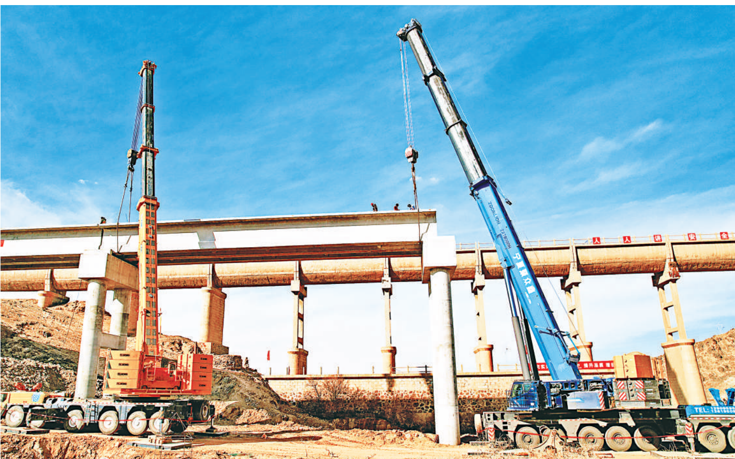
11月29日,宁夏固海扬水灌区续建配套与现代化改造工程长山头渡槽T型梁吊装成功。固海三千渠跨清水河长山头水库渡槽改造工程总投资6558万元。目前,工程已完成槽壳和T型梁预制任务,正在进行主坝段吊装,计划2025年3月完成建设任务,确保春灌顺利运行。 本报记者 裴云云 摄
